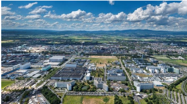
Sanofi im Industriepark Höchst Blick auf den Süden des Industriepark Höchst mit dem Sanofi BioCampus Frankfurt von Sanofi in Deutschland.
