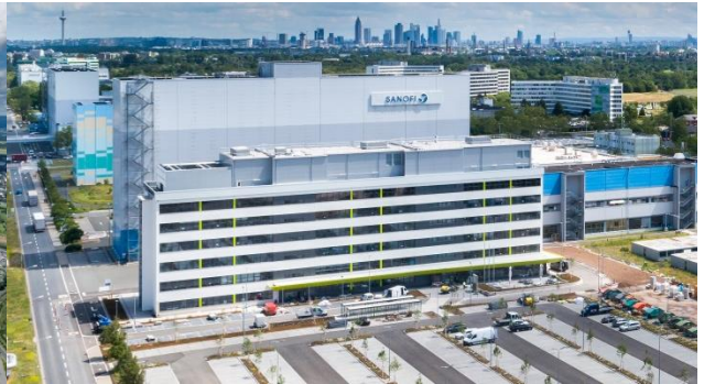
Investition in den Standort Frankfurt: Das neue Devices Technology Center erweitert den BioCampus Büro- und Laborgebäude in direkter Nachbarschaft zur Pen-Fertigung im Süden des Industrieparks Höchst.
